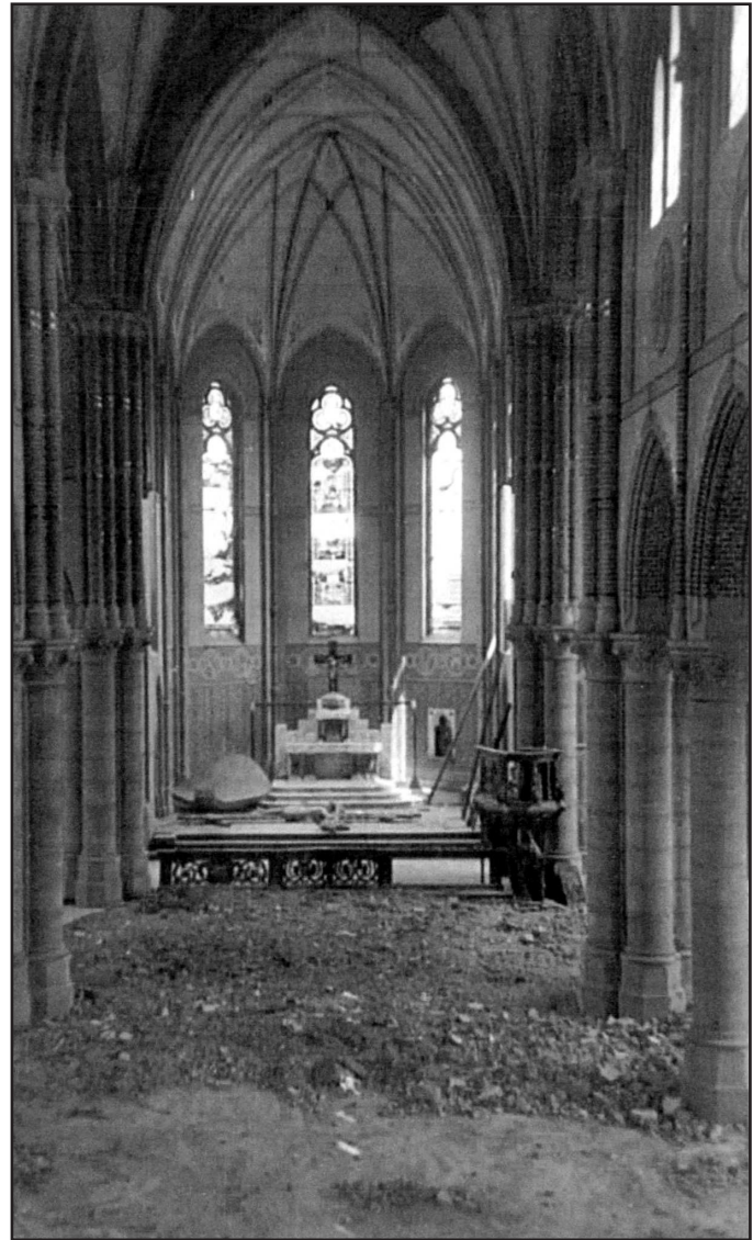
De oorlogsschade opgelopen tijdens WO II.
